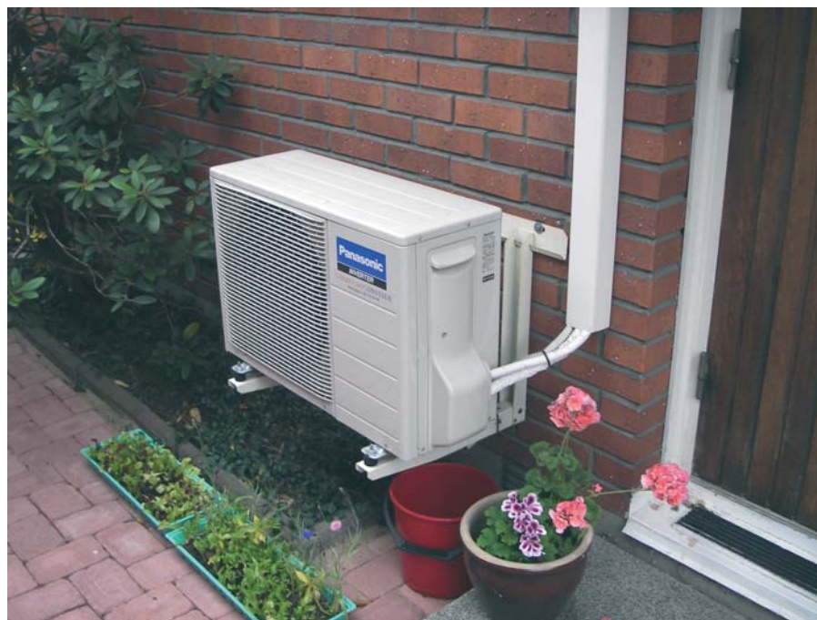
Utedelen av en luftvärmepump. Hinken under samlar upp kondensvatten när pumpen ställs om för kylning sommartid.
