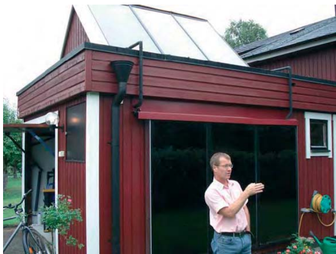
Olle Sjöstedt visar söderriktningen framför solfångare på garageväggen och på stativ på garagetaket. Ingen håltagning gjordes i taket. Solfångaren är totalt 10 m 2 .
