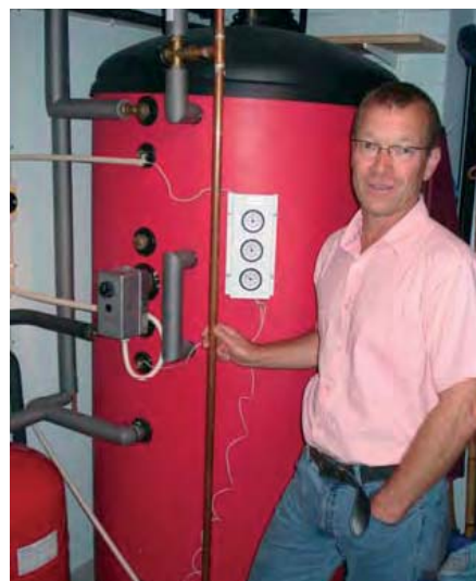
Solvärmetanken på 750 liter är välisolerad med 90 mm PUR.
