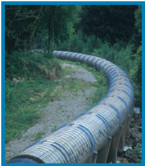
Kungfors kraftstation, Sandviken, turbinledning på fundament.
