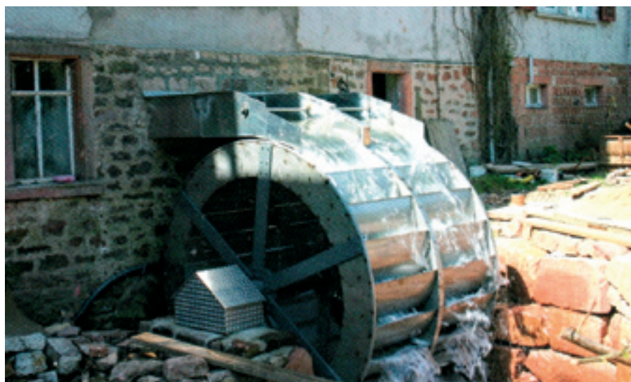
Det nybyggda vattenhjulet provkörs.
