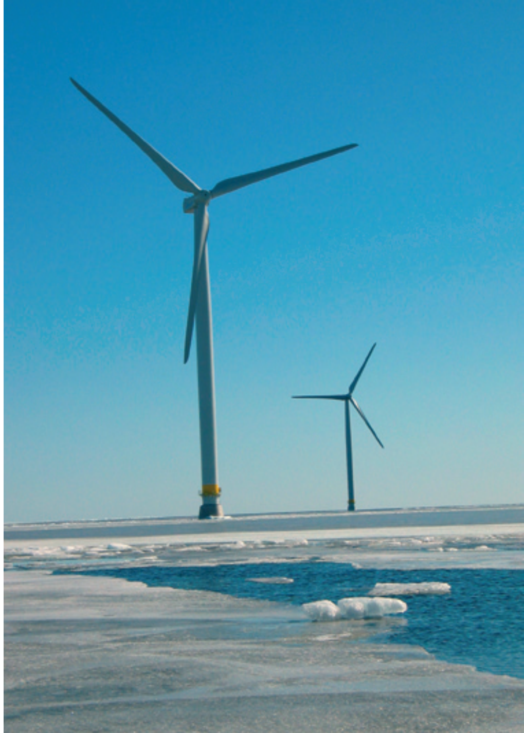
Vindpark Vänern består av 10 st WinWind 3 MW-verk.
