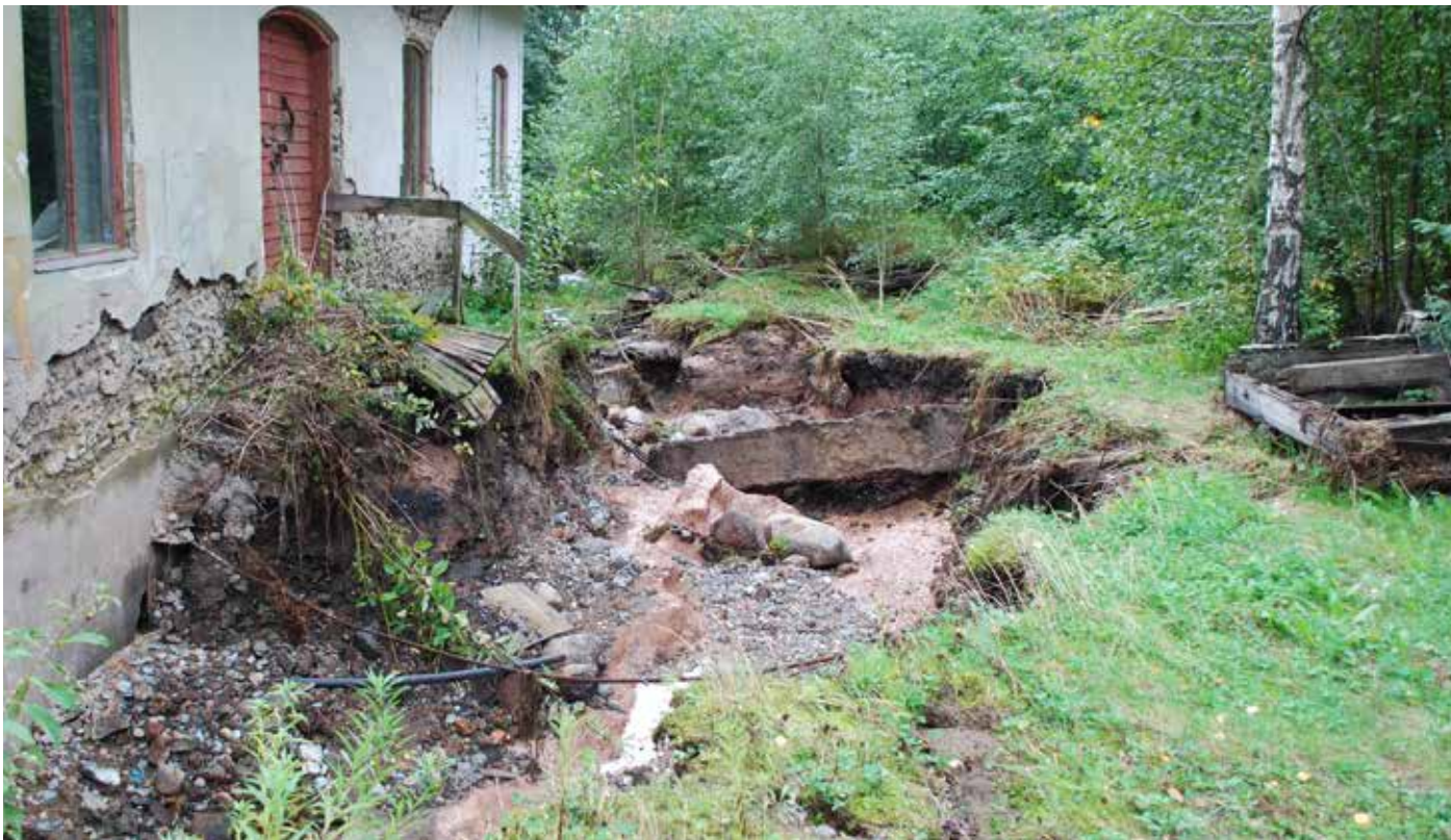
Vid ett lokalt skyfall kom 174 mm regn på 6 timmar. Det fick till följd att kraftverksdammen översvämmades och vattenflödet skapade djupa fåror runt stationen. Inne i kraftverket stod vattnet nära två meter över golvet.
