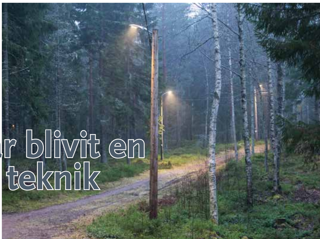
Slingan i Storfors är på 2,5 km och har 96 LED-armaturer.
