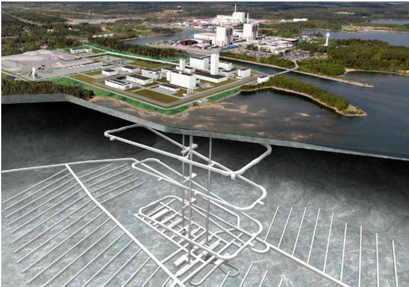
Bild över det tänkta slutförvaret av det svenska kärnavfallet under de tre reaktorerna i Forsmark. Platsen är inte ideal då det i historisk tid inträffat flera kraftiga jordbävningar. Bild: SKB.
